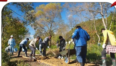
作業風景(土運び)
