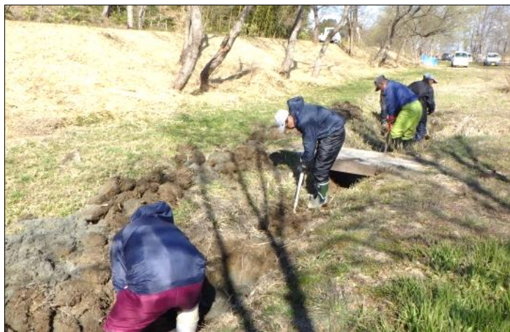
水路の堀上げ作業
