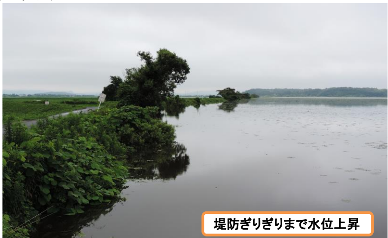
冠水した2工区
